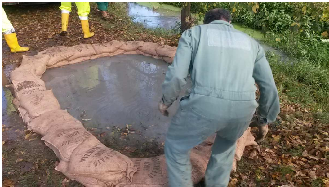
Figura 2-14: Fontanazzo con coronella di sacchetti di sabbia nei pressi dell'abitato di Corbola.
